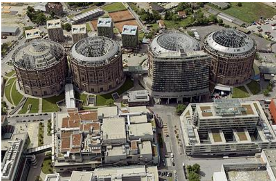
Abb.: 23 / Luftbild der umgebauten Gasometer mit umliegenden Büro- und Wohnhausanlagen
