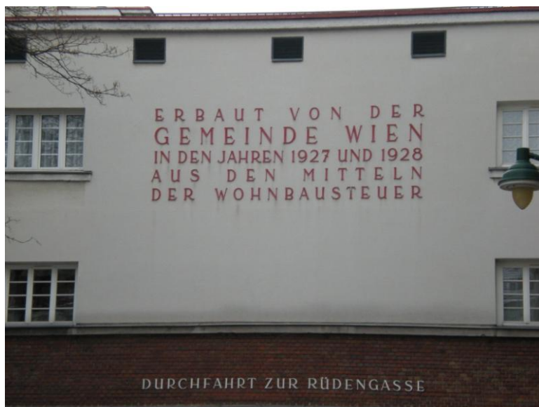
Abb.: 19 / Detailansicht aus dem Rabenhof, mit einer für Gemeindebauten typischer Beschriftung (und im Originalzustand typischen Fenstern)
