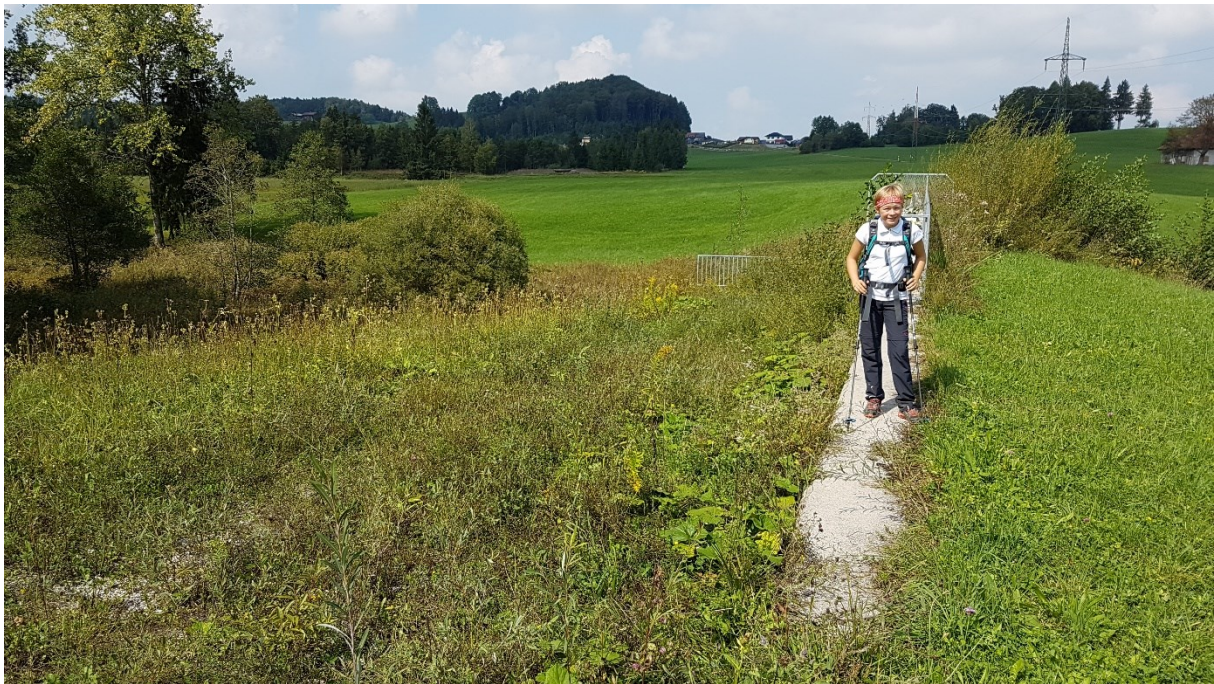
Abbildung 39: Künstliche Staumauer im Koppler Moor
