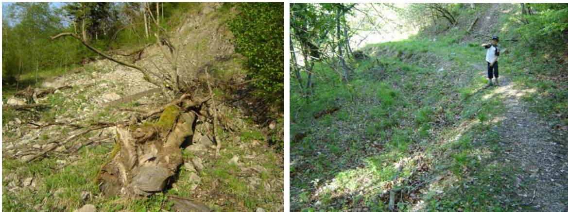
Abb. 8a, b: Der über 200m lange und ca. 20m breite aktive Schuttstrom an der Basis des Kalkofenzugs im Kontakt zum unterlagernden Buntmergel gehört bis heute zu den aktivsten im randlichen Bereich des gesamten Gschlifgraben-Rutschgebiets. Im Unterschied zu den zentralen Rutschkörpern aus aufgeweichtem Buntmergel auf festem handelt es sich hier um grobblockige Kalke auf Buntmergel (links); durch Wasserinfiltration kam es auch an dieser Stichstraße zu einer 2m tiefen Absenkung des Geländes im Laufe von wenigen Jahren (Fotos: J.T. Weidinger/W. Vortisch 2005).
