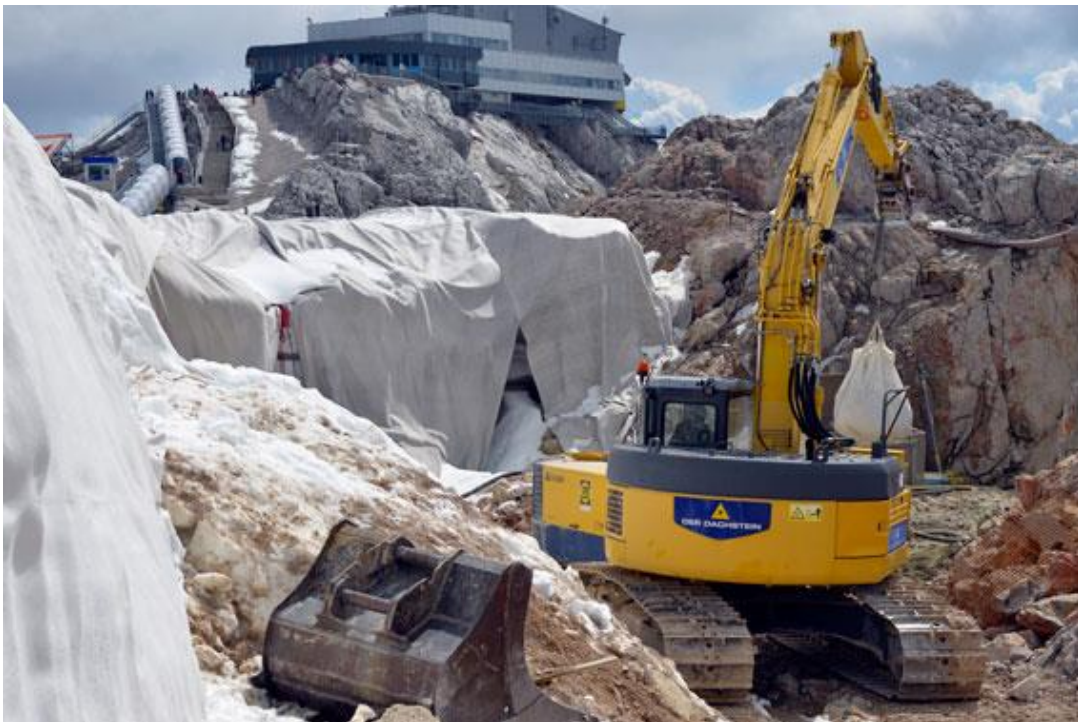
Abb. 6: Baustelle Eispalast im Sommer 2012.
