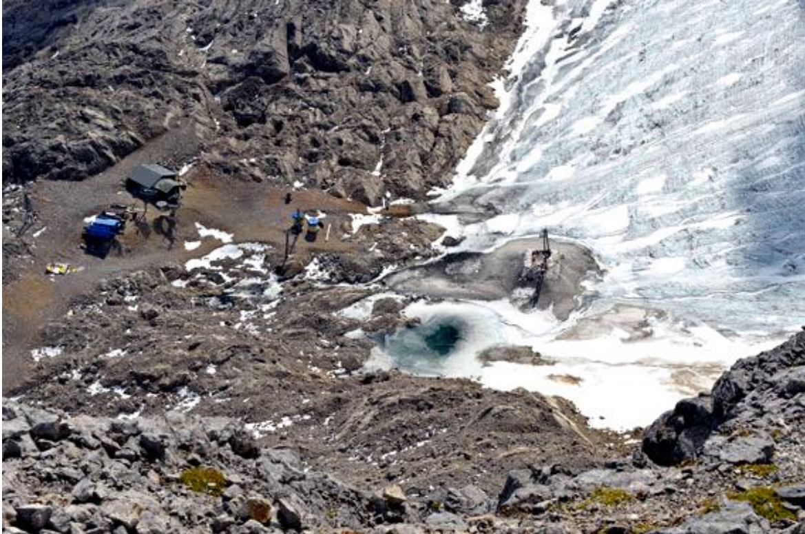
Abb. 7: Durch Schneeeinbringung mit Pistenraupen konnte in den Bereich des temporären Eissee und der Liftstütze ein weiteres Abschmelzen des Eises und Schnees verhindert werden. Durch diesen Kunstgriff verkleinerte sich der Eissee.
