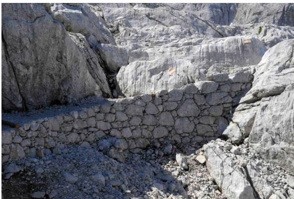
Abb. 8 (links): Trockenmauer der Wegbefestigung zur Simonyhütte. Östliches Dachsteingebirge, 2100 m
