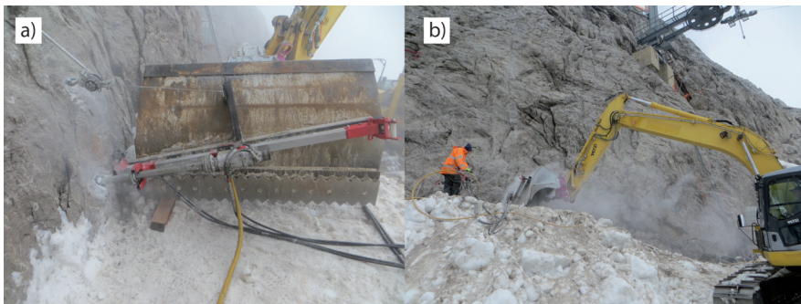
Abb. 2: Bohrtätigkeiten am neuen Permafrostbohrlochstandort: a) pneumatische Bohrgerätschaft, welche an einer Baggerschaufel verankert wurde; b) der Bohrlochstandort und seine nähere Umgebung; zu beachten die steile, aus Dachsteinkalk aufgebaute Felswand sowie die Liftbergstation im Hintergrund.
