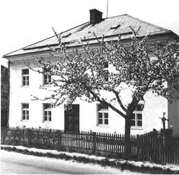
Das alte Volksschulgebäude aus 1890 war ein freundliches Haus (heute Pfarrhof)
