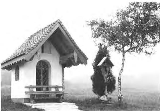
Die neue Barhammer-Kapelle
