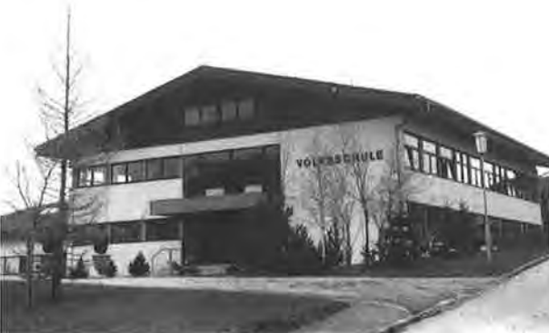
1980 konnte die neue Volksschule eröffnet werden.
