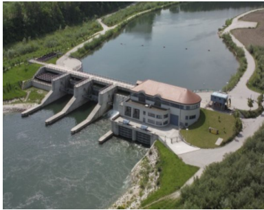
Abbildung 7: Laufkraftwerk in Lambach
