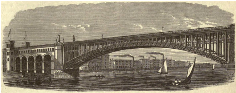
Figure: Eads Bridge über den Mississippi River, kontrolliert von TRA
