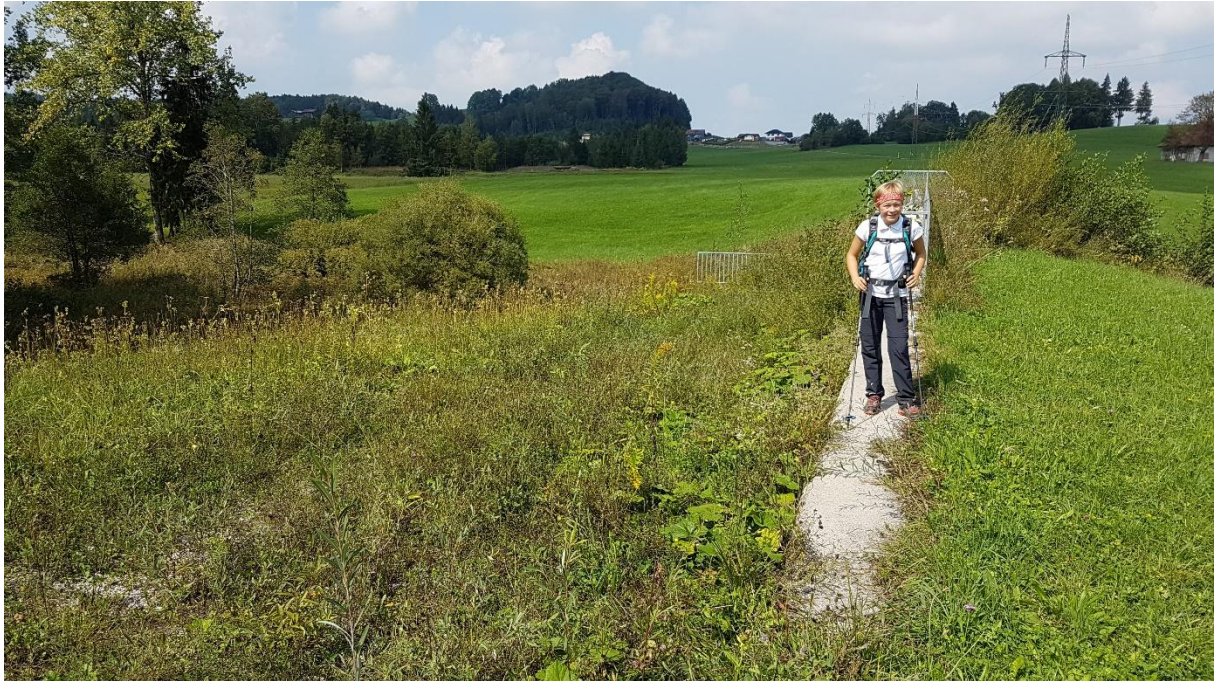
Abbildung 39: Künstliche Staumauer im Koppler Moor
