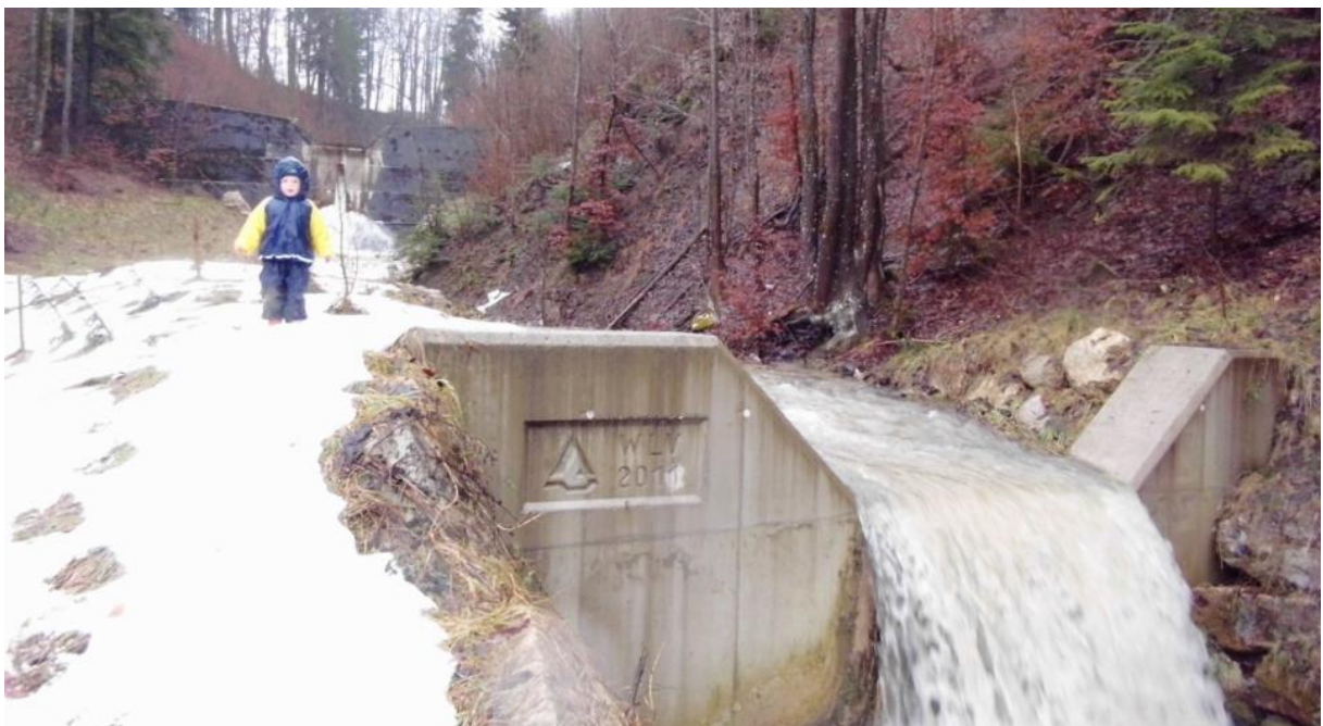
Abbildung 18: Verbauungen entlang des Koppler Bachs
