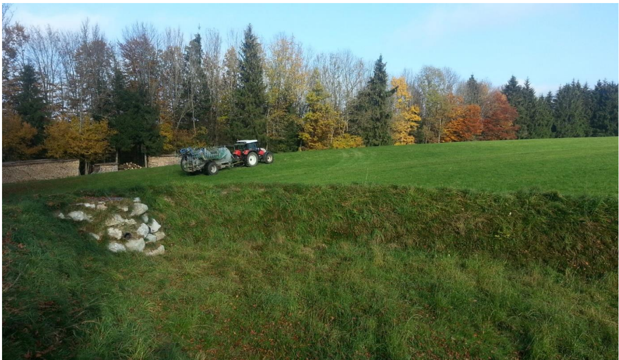
Abbildung 20: Retentionsbecken am Park & Ride Parkplatz Sperrbrücke
