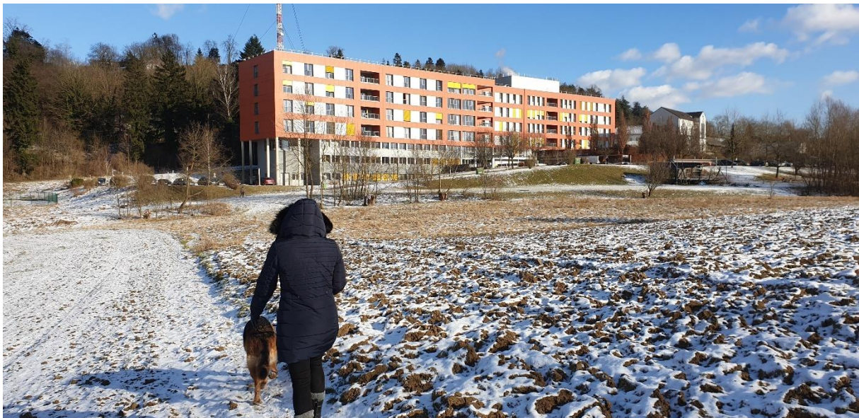
Abbildung 19: Pflegeheim Sonnenhof Freinberg Quelle: eigene Aufnahme
