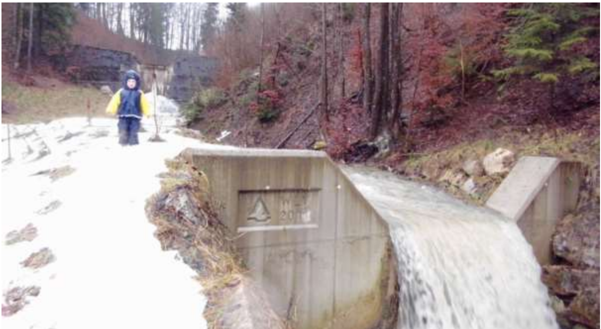
Abbildung 18: Verbauungen entlang des Koppler Baches
