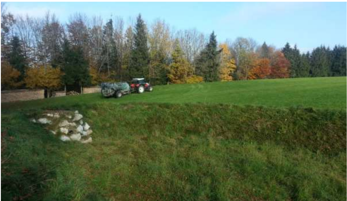
Abbildung 20: Retentionsbecken am Park & Ride Parkplatz Sperrbrücke
