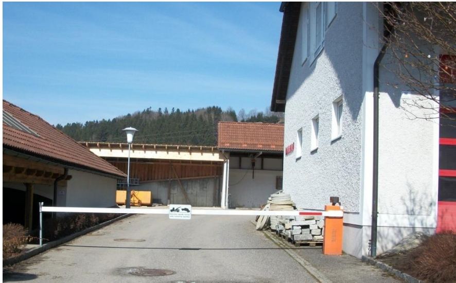
Sicht auf die Bauhof-Einfahrt und die provisorische Überdachung, da ebenfalls ein Platzmangel vorherrscht. Foto: Oliver Hierschläger
