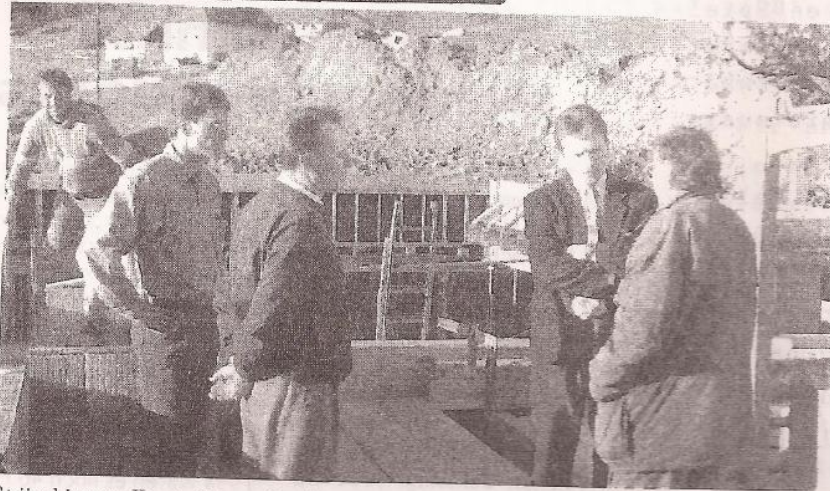
Ständiger Kontakt mit Vertretern der Baufirma und dem Bauleiter Ing. Forsterleitner vom Büro unseres Ortsplaners Dr. Englmaier (im Bild ganz rechts).
