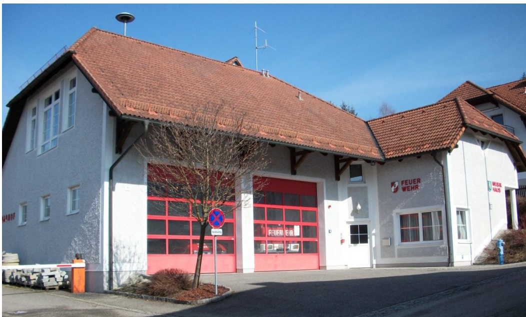
Sicht auf die Tore der Feuerwehr. Problem: Es gibt nur 2 Tore, doch es werden 3 Fahrzeuge benötigt. Im OG findet sich der Musikverein, der auch über zu wenig Platz klagt. Foto: Oliver Hierschläger
