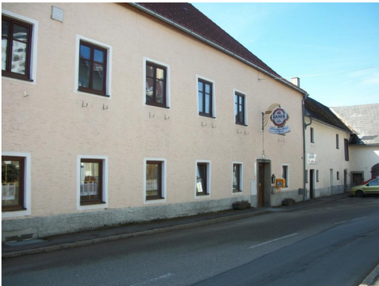
Gasthaus zur Post, Ansicht von der Ortseinfahrt Foto: Oliver Hierschläger
