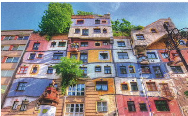
M6 Dach- und Fassadenbegrünung in Wien
